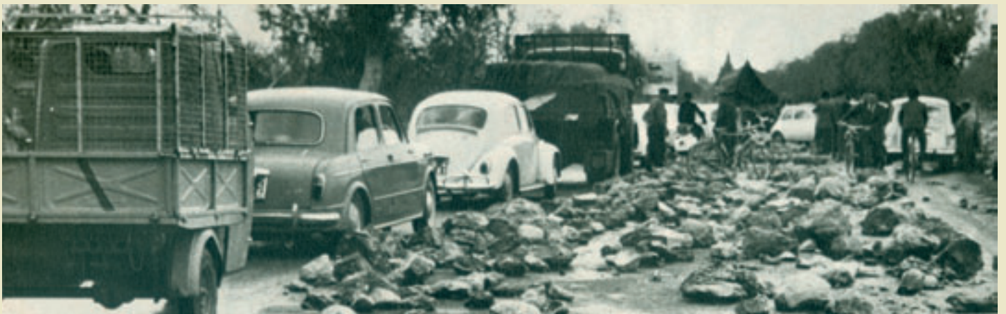
La statale 115 dopo gli scontri.
